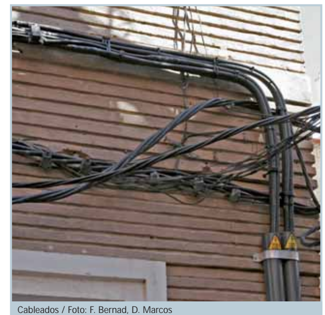
Cableados / Foto: F. Bernad, D. Marcos
