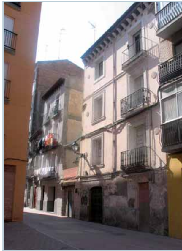
Casa deshabitada con solares colindantes
